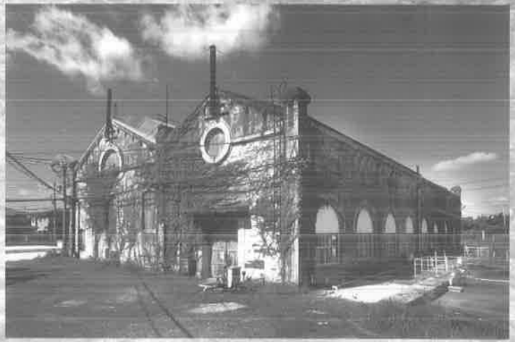
官営八幡製鐵所遠賀川水源地ポンプ室 (中間市・非公開施設) 写真提供/新日鐵住金(株)八幡製鐵所
